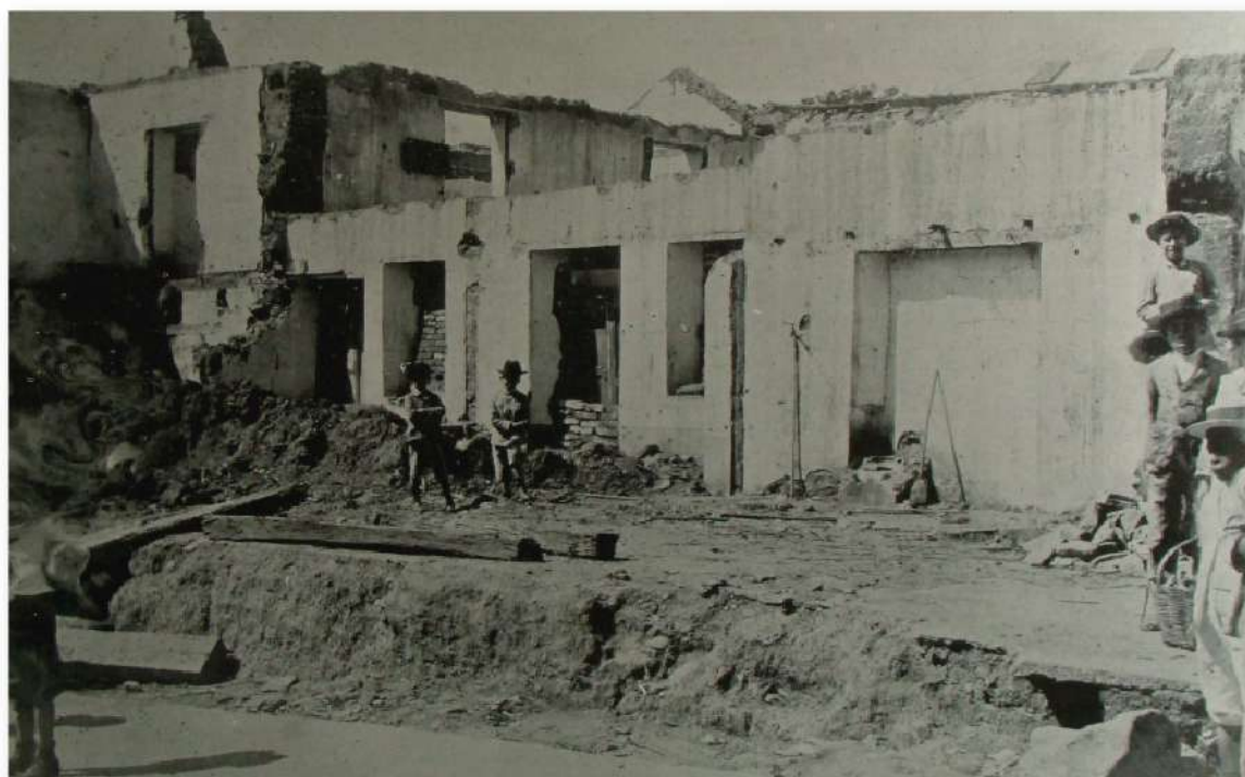
Demolición de la casa de la esquina de Los Traposos, hacia el S. O. Caracas.
