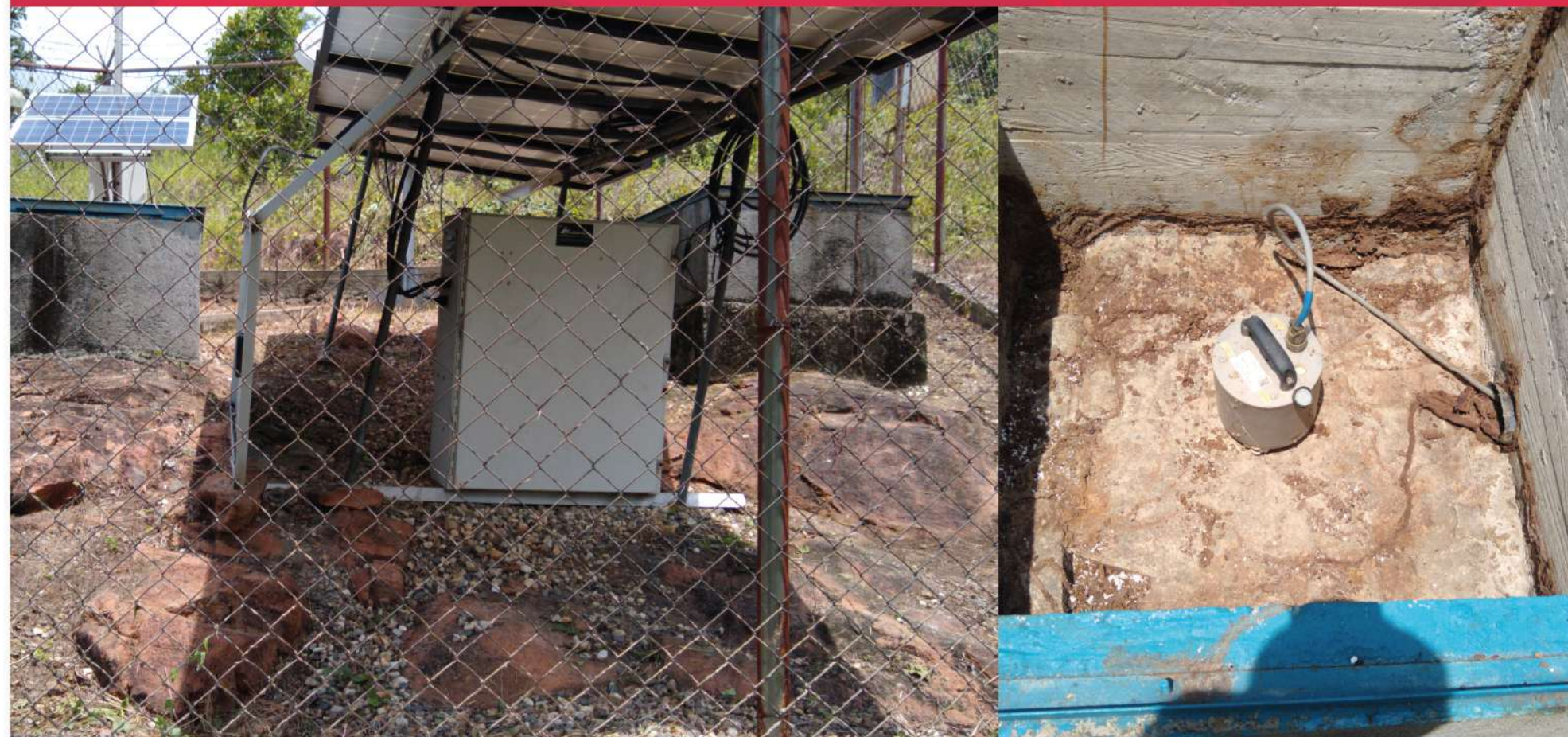
Sismómetro de medición. Fuente: Miguel Castro (2019).
