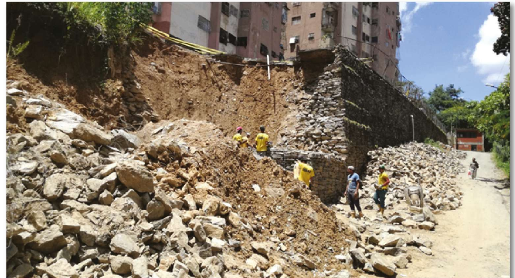
Deslizamientos en zonas populares de Caracas, activados por lluvias torrenciales y por efectos antrópicos (cargas normales por edificaciones e inyección de aguas residuales). La foto superior pertenece a un conjunto residencial de Petare, en la cual la pared perimetral que rodeaba la urbanización colapsó por la saturación del suelo en temporada de lluvias, la foto inferior pertenece a un deslizamiento en ladera del barrio Fenix, Petare, originado por la conjugación de efectos antrópicos y saturación de suelos. En los dos casos se observa el gran espesor de suelo residual en la cual están asentadas las viviendas o urbanismos. Fuente: Informe técnico de Funvisis (2016).
