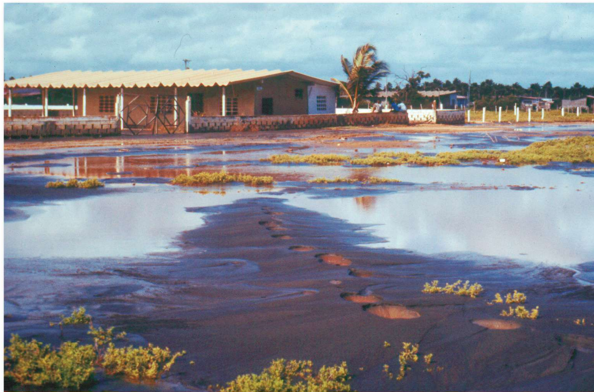
Volcanes de arena gris alineados, así como agua expulsada por licuación de suelos durante los sismos de abril y mayo de 1989 en Boca de Tucuyo estado Falcón. Observe que la casa y los muros perimetrales perdieron la horizontalidad. Fuente: Carlos Beltrán (1989).
