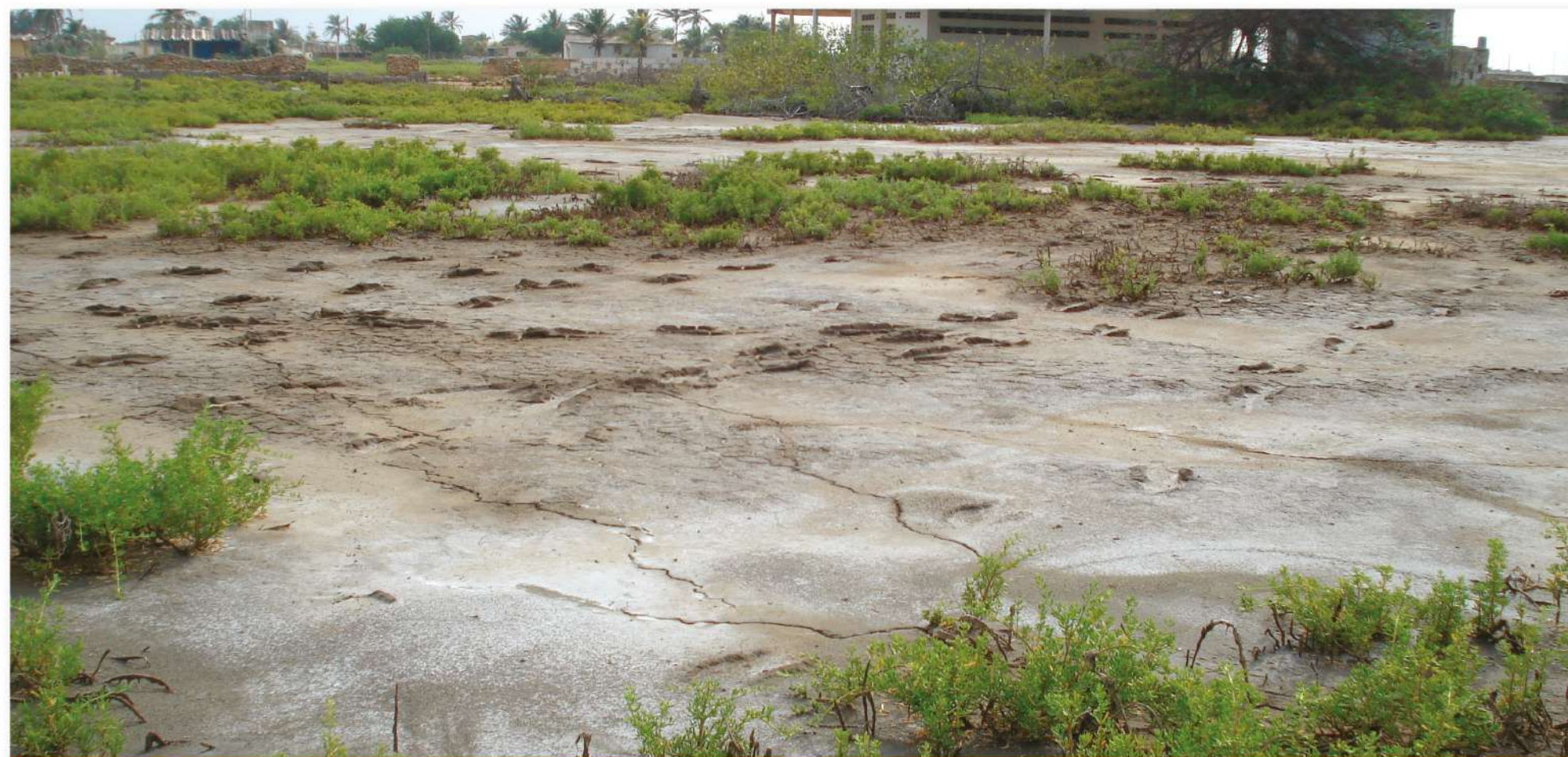
Relajamiento lateral y evidencias de licuación de suelos en Boca de Tocuyo del sismo del 12 de septiembre de 2009. Fuente: Luz M. Rodríguez.
