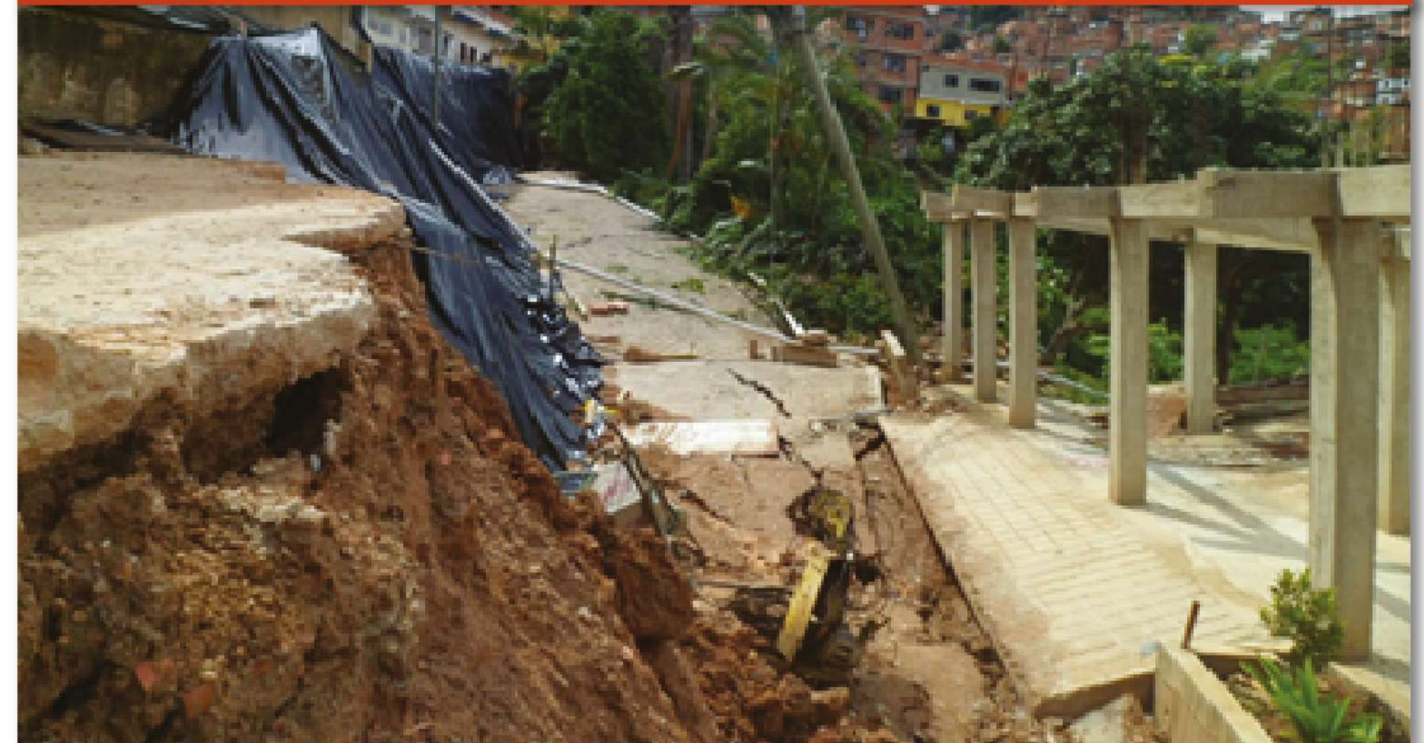
Deslizamientos en zonas populares de Caracas, activados por lluvias torrenciales y por efectos antrópicos (cargas normales por edificaciones e inyección de aguas residuales). La foto superior pertenece a un conjunto residencial de Petare, en la cual la pared perimetral que rodeaba la urbanización colapsó por la saturación del suelo en temporada de lluvias, la foto inferior pertenece a un deslizamiento en ladera del barrio Fenix, Petare, originado por la conjugación de efectos antrópicos y saturación de suelos. En los dos casos se observa el gran espesor de suelo residual en la cual están asentadas las viviendas o urbanismos. Fuente: Informe técnico de Funvisis (2016).
