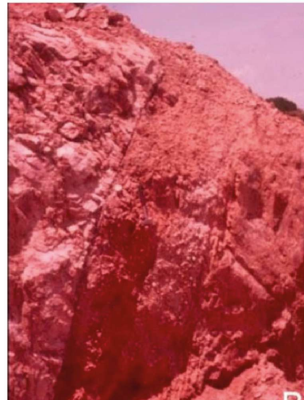
Vista al este de una brecha de falla N45°W 70N) encontrada en excavación en la Urbanización Ávila al pie de la Cota mil cortando gneises milonitizados a la izquierda y esquistos anfíbolíticos a la derecha. Fuente: André Singer.
