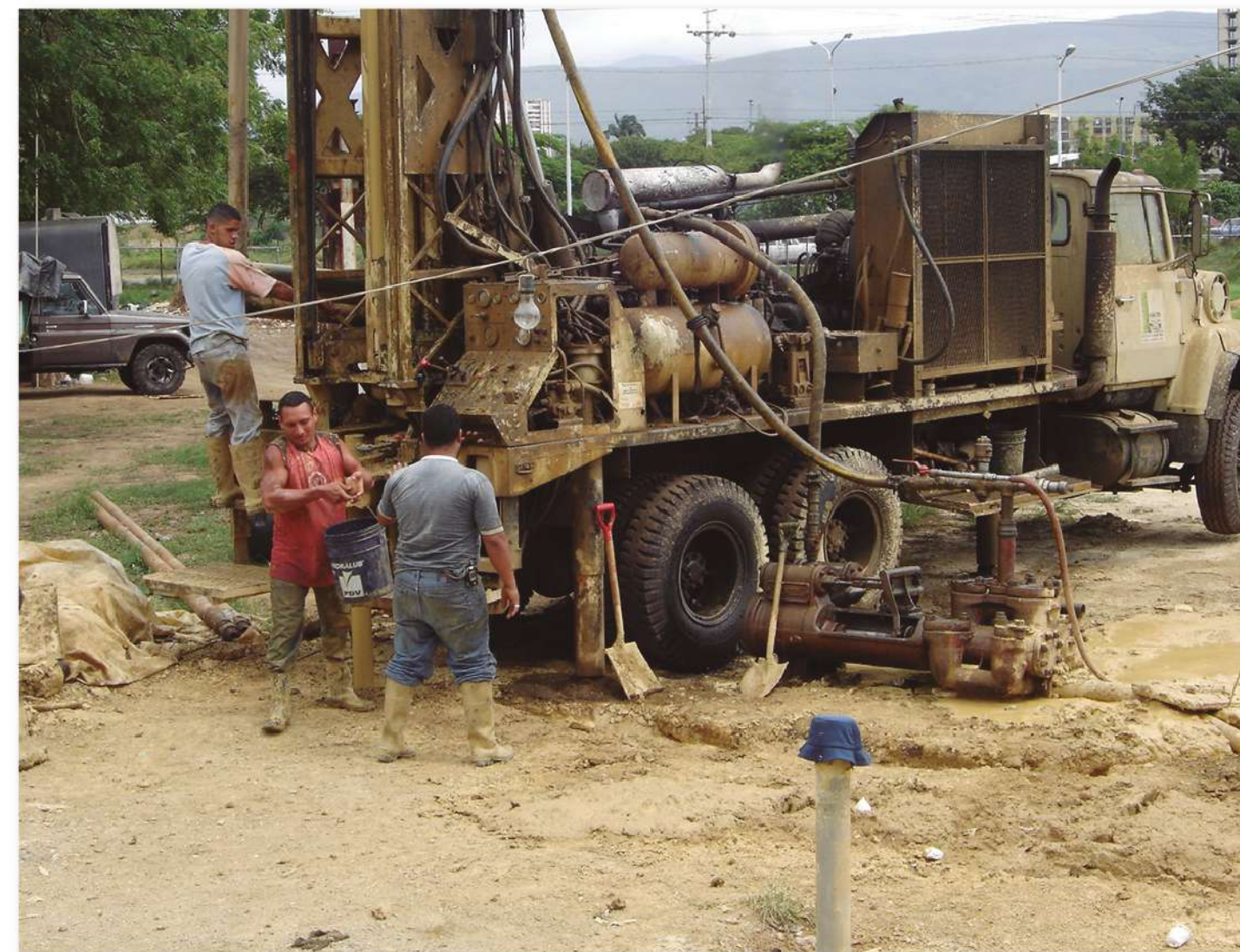
Perforación geotécnica en Barquisimeto (2006).
