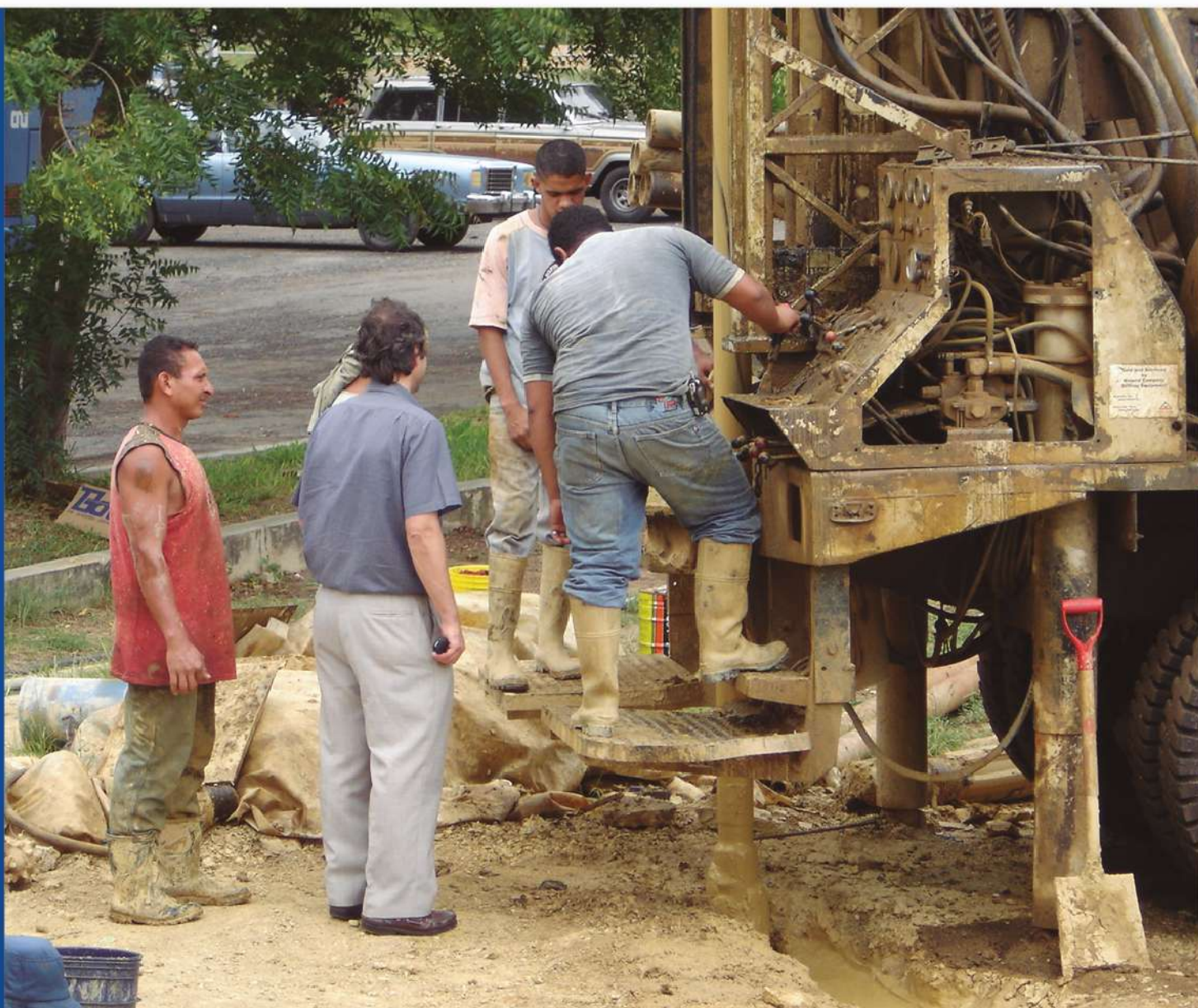
Perforación geotécnica en Barquisimeto (2006).
