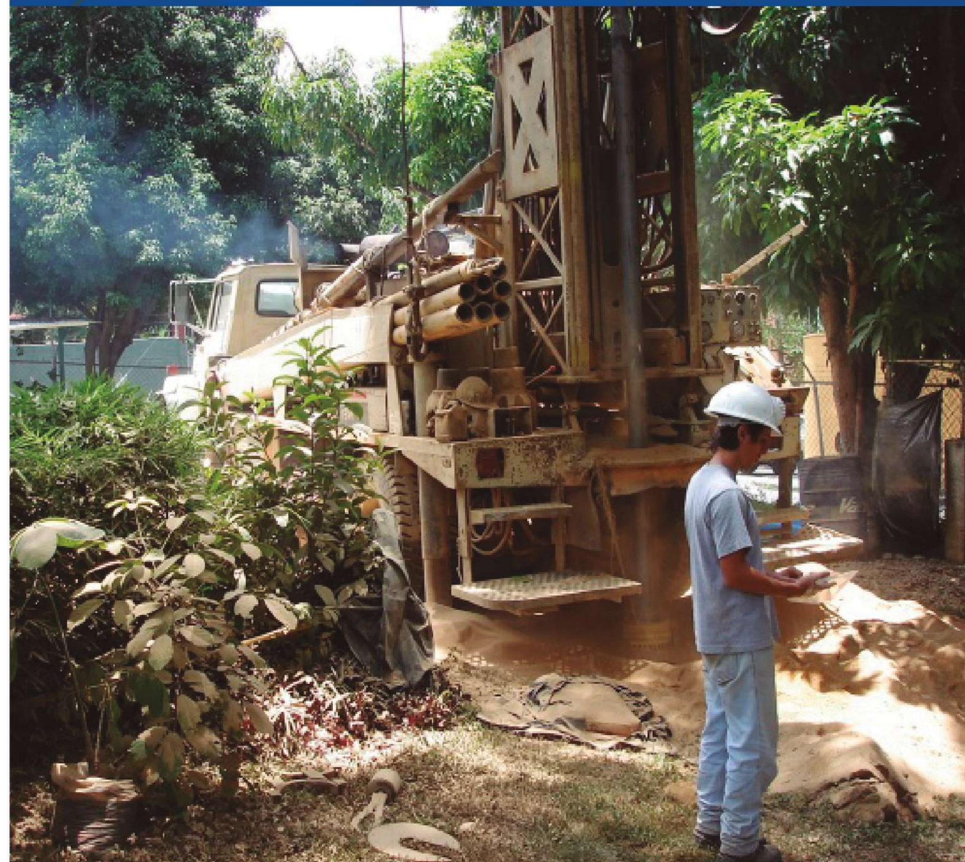
Perforación para instalación de observatorio acelerográfico en Caracas (2005).
