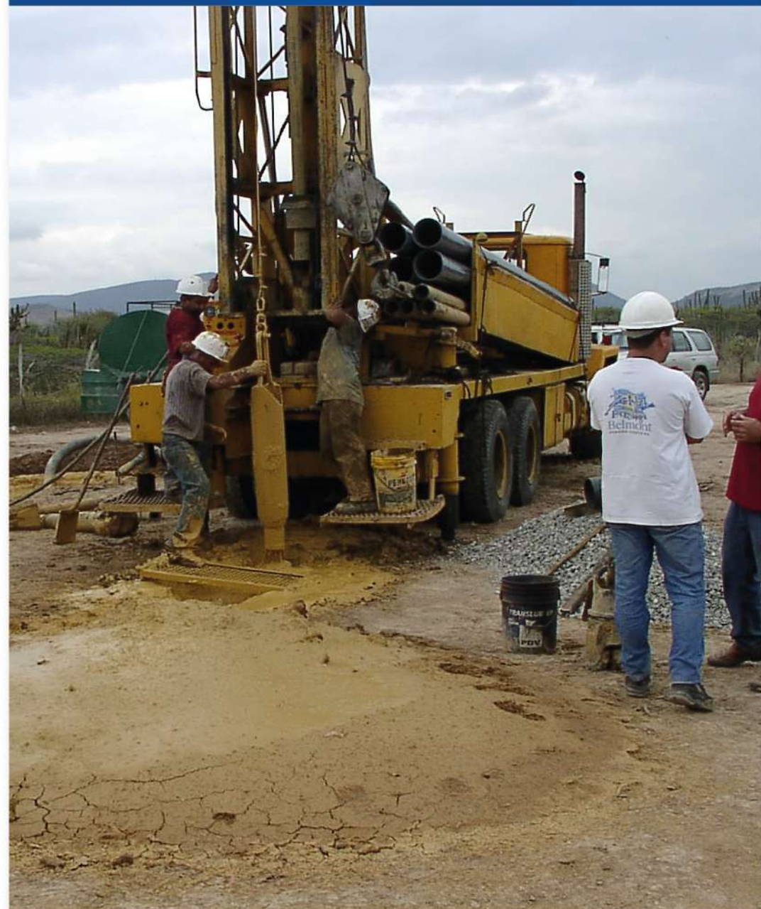
Proyecto GEODINOS, 2003: Perforación de pozos para una voladura, estado Falcón.
