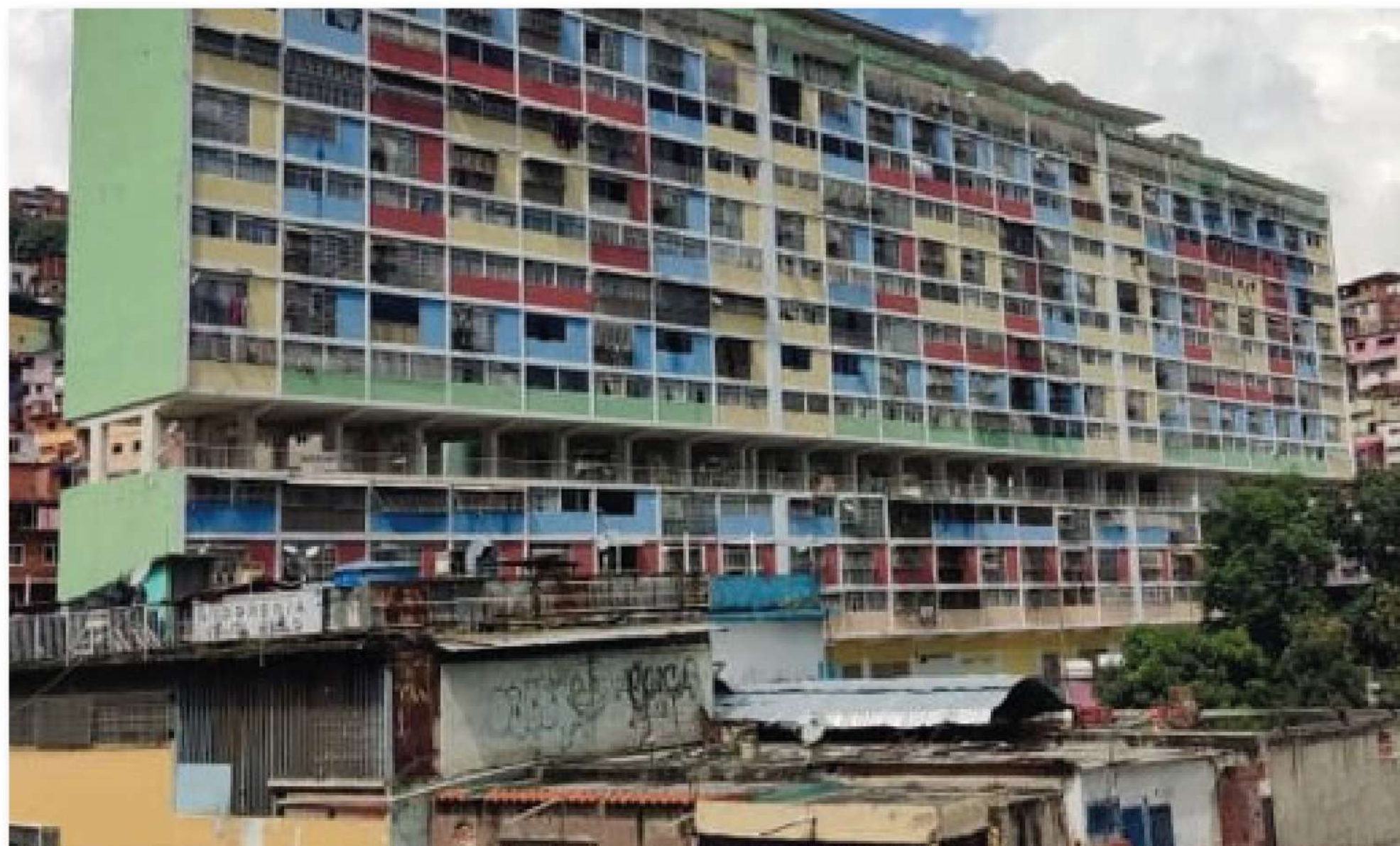
Edificio Residencia Cerro Grande, Av. Intercomunal, parroquia El Valle, Municipio Libertador, Distrito Capital. Construido en la década de los años 50. Fuente: Mario Rendón (2022).
