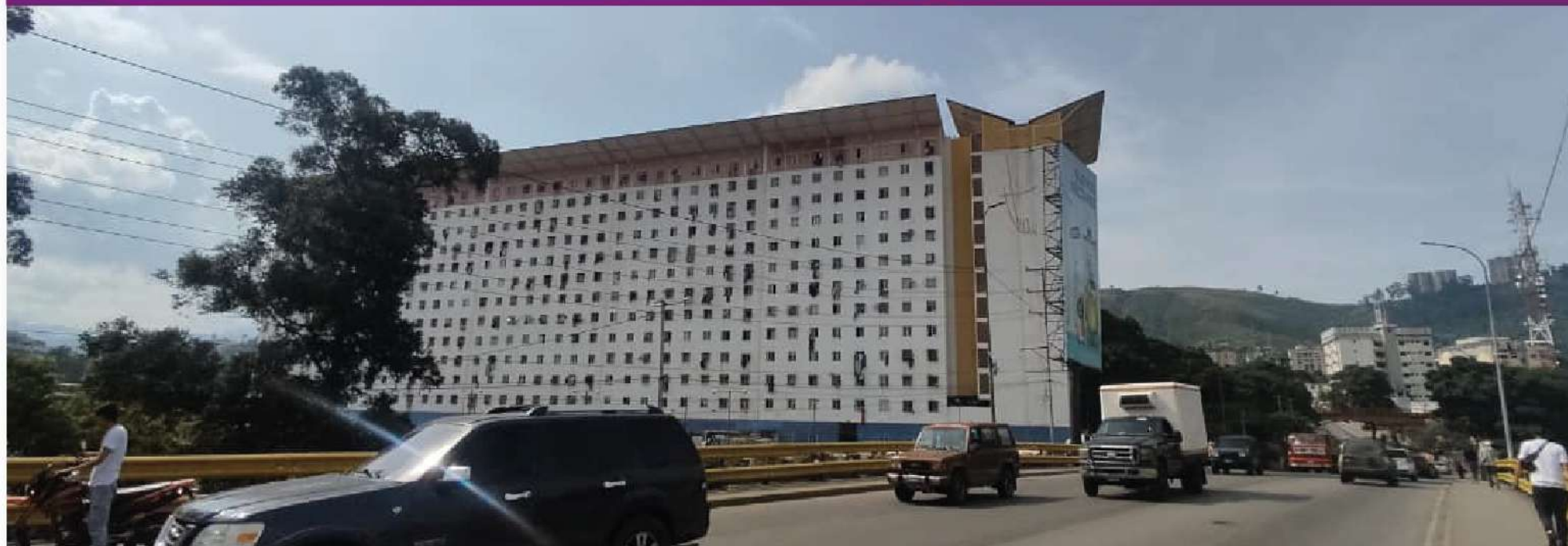
Edificios Misión Viviendas, Puente de los Leones, sector La Paz, El Paraíso, Municipio Libertador, Distrito Capital. Fuente: Mario Rendón (2012).
