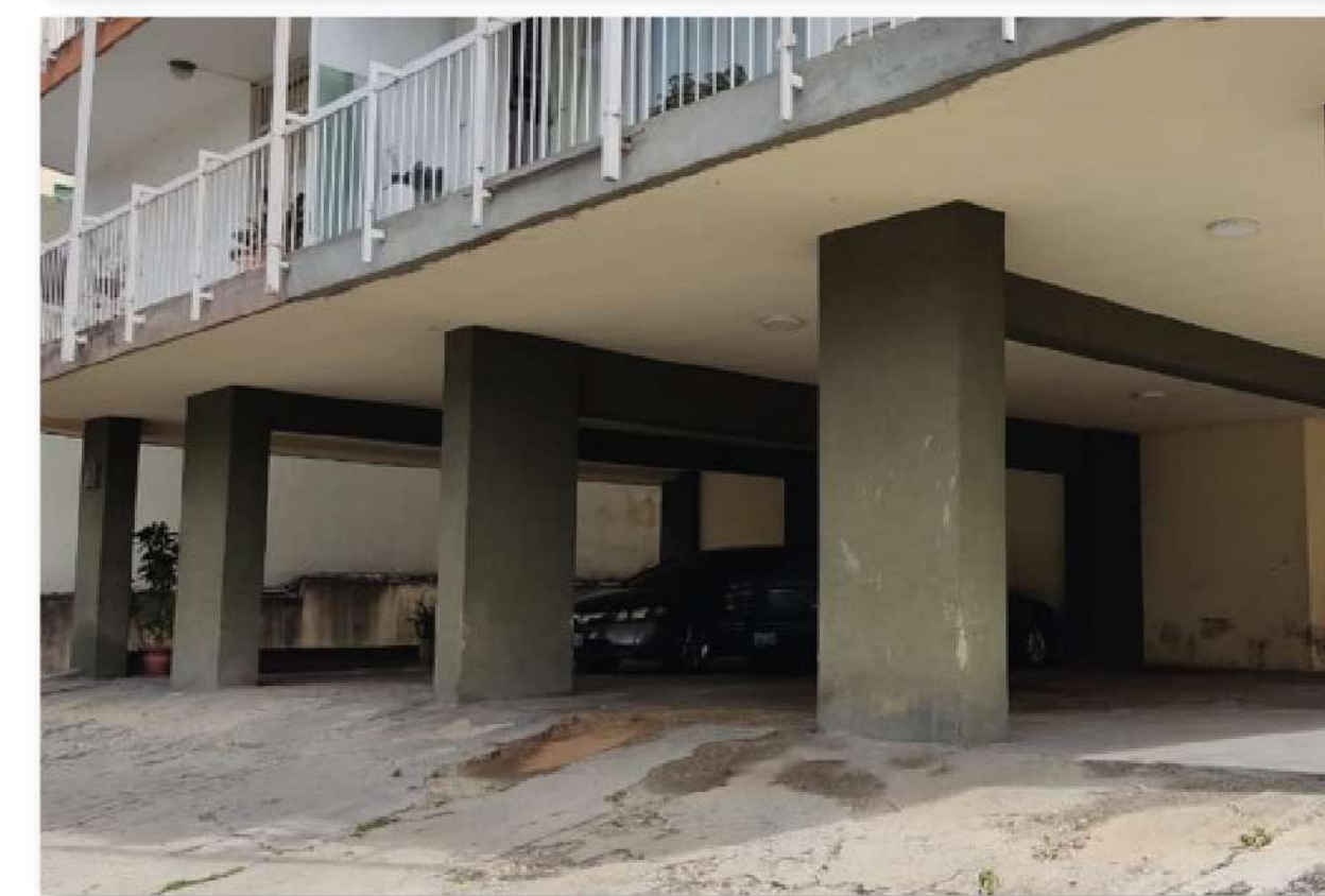
Vigas en una sola dirección, edificio Obel, Altamira, Municipio Chacao, Caracas. Fuente: Mario Rendón (2022).
