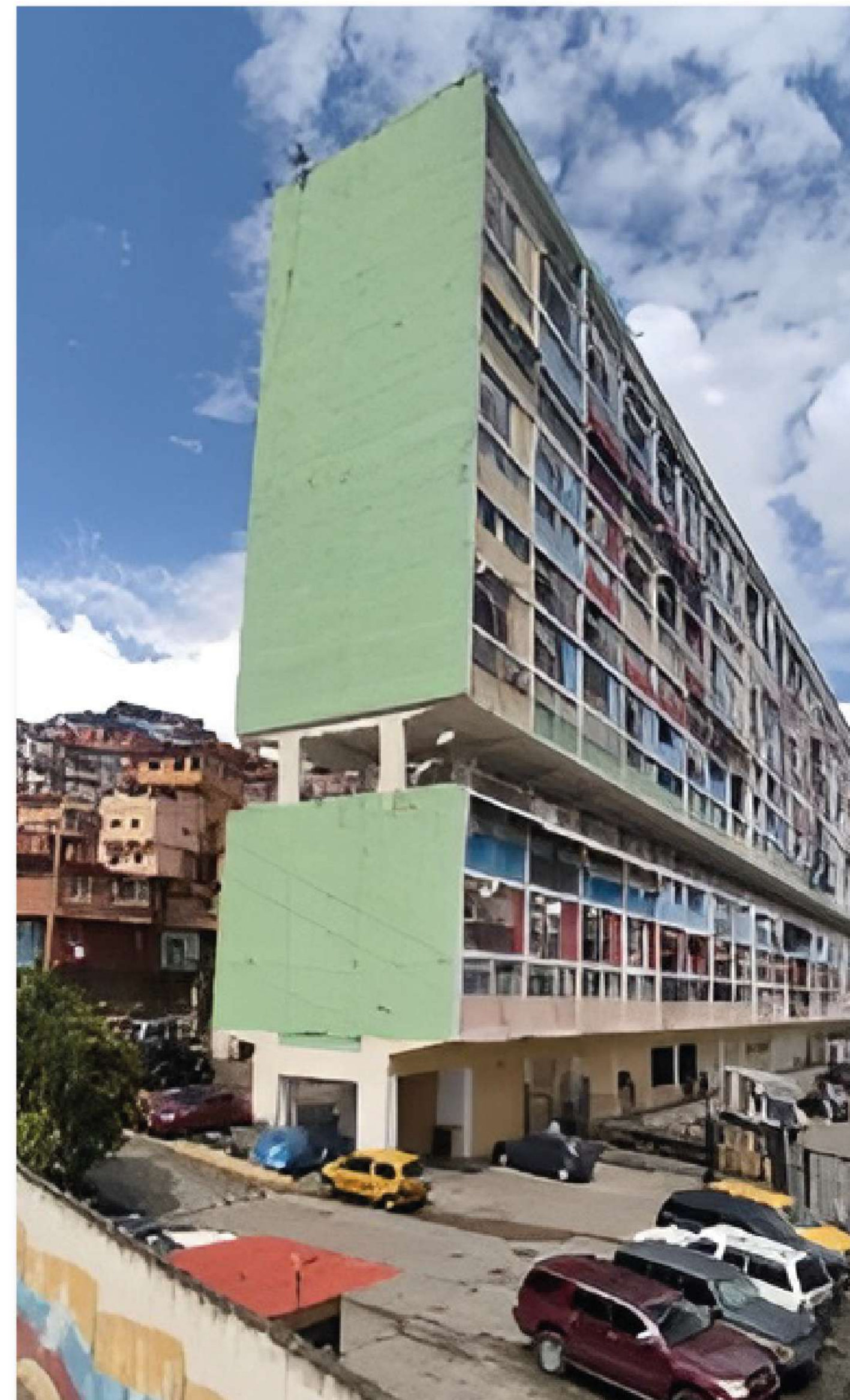
Edificio Residencia Cerro Grande, Av. Intercomunal, parroquia El Valle, Municipio Libertador, Distrito Capital. Construido en la década de los años 50. Fuente: Mario Rendón (2022).
