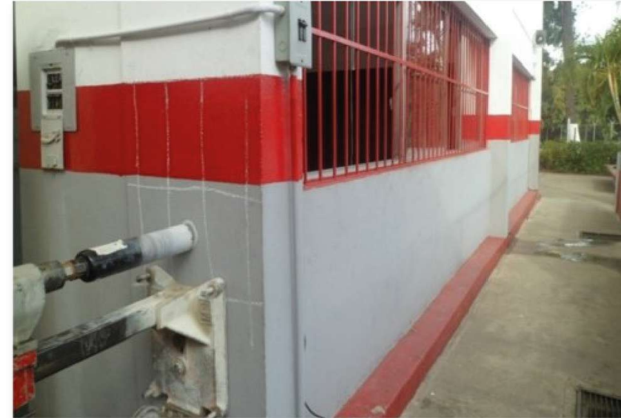
Estación de Bomberos El Valle, Av. Intercomunal del Valle, Distrito Capital. Fuente: Mario Rendón (2022).
