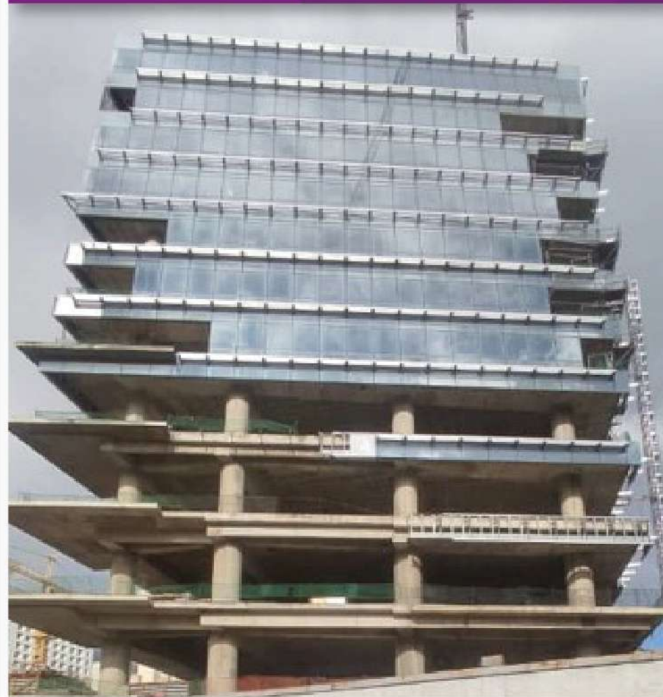
Edificación en construcción. Av. Francisco de Miranda, Chacao, Distrito Capital. Fuente: Mario Rendón (2022).
